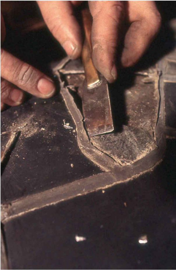
FIGURA 6. Procés de restauració de la rosassa de Santa Maria del Mar. Extracció dels vidres fracturats de la xarxa de plom. (Pere Valldepérez)
