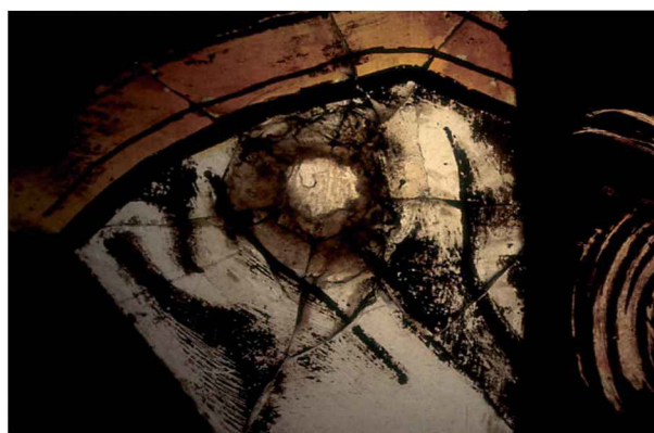
FIGURA 3. Barcelona. Santa Maria del Mar. Detalls de la rosassa. Agressions visibles al vitrall derivades de l'acció de l'home.
